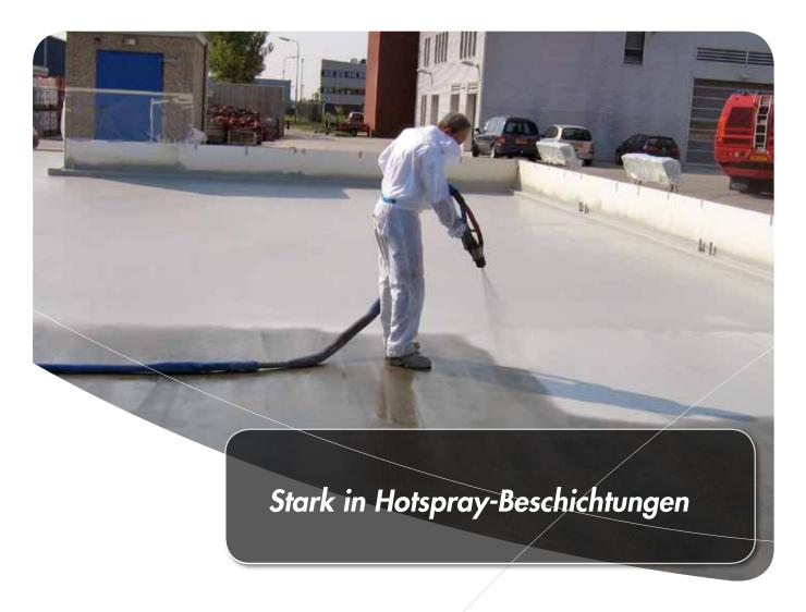
Prokol ist spezialisiert auf die Entwicklung und Produktion von Polyurea-, Polyurethan- und Hybrid Hotspray-Beschichtungen. Diese Rocathaan Hotspray-Beschichtungen werden mittels spezieller Sprühapparatur appliziert.
