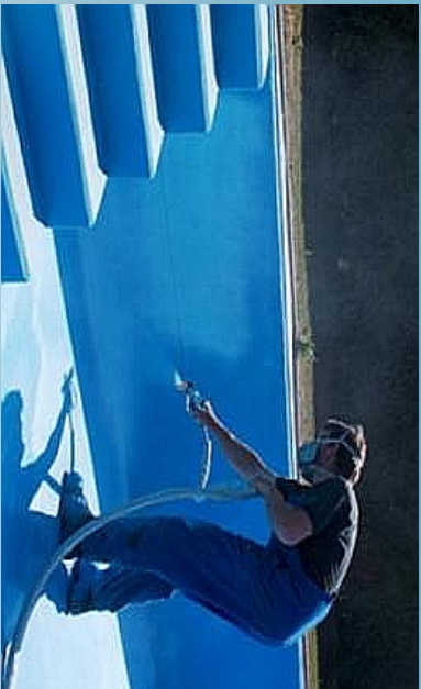
4. Auftragung des UV-/ Chlor- beständigen Topcoats
